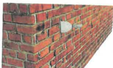
Začištění povrchu vrtu
