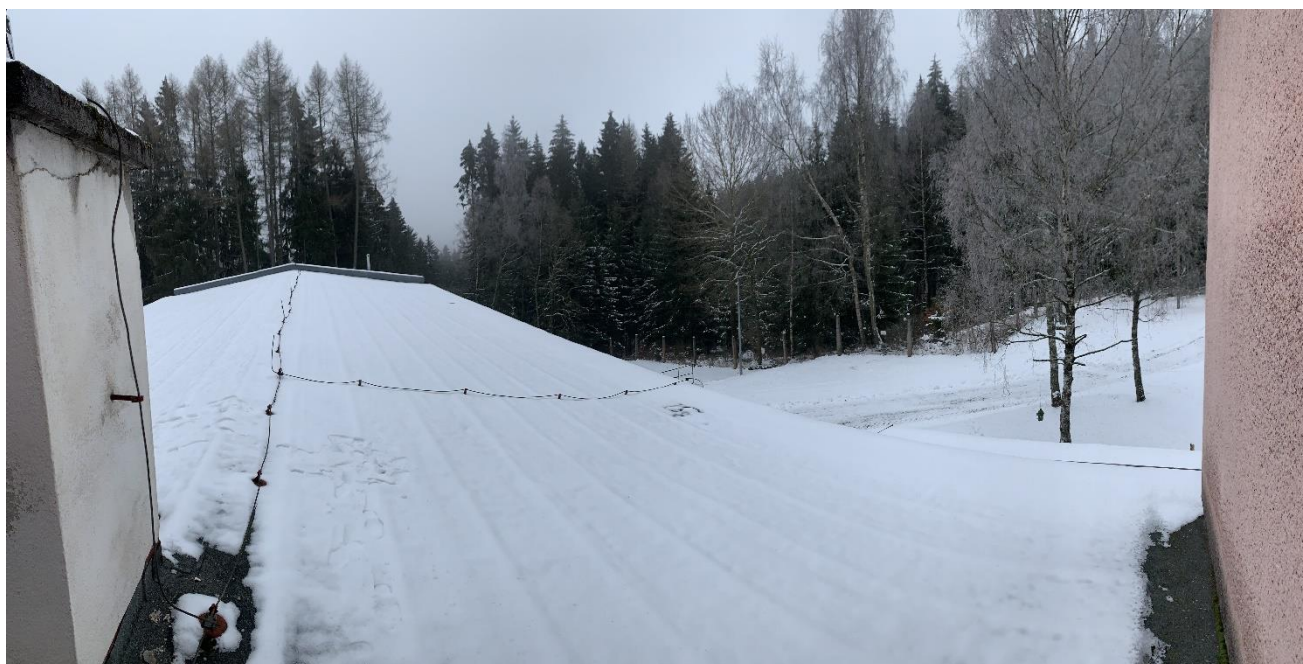
Pohled na jižní část střechy budovy úpravny vody Rotava pro instalaci FVE
