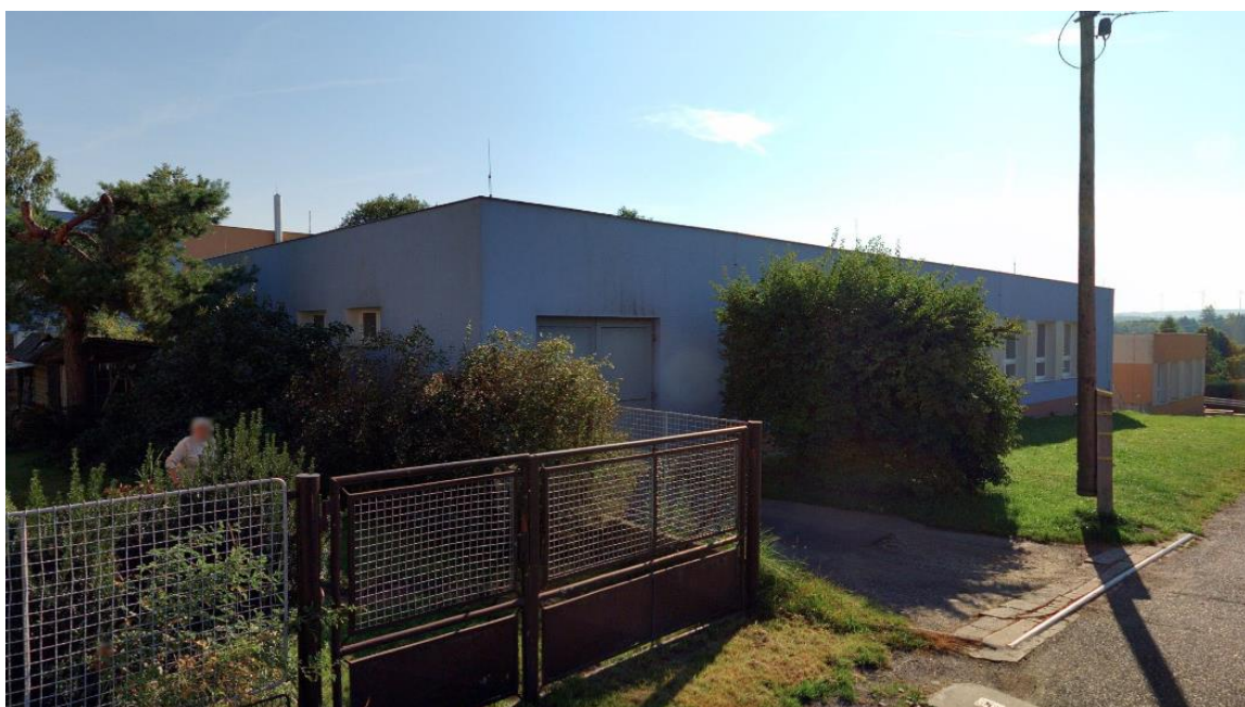
Zadní pohled budova ZŠ pro FVE na pozemku 678
