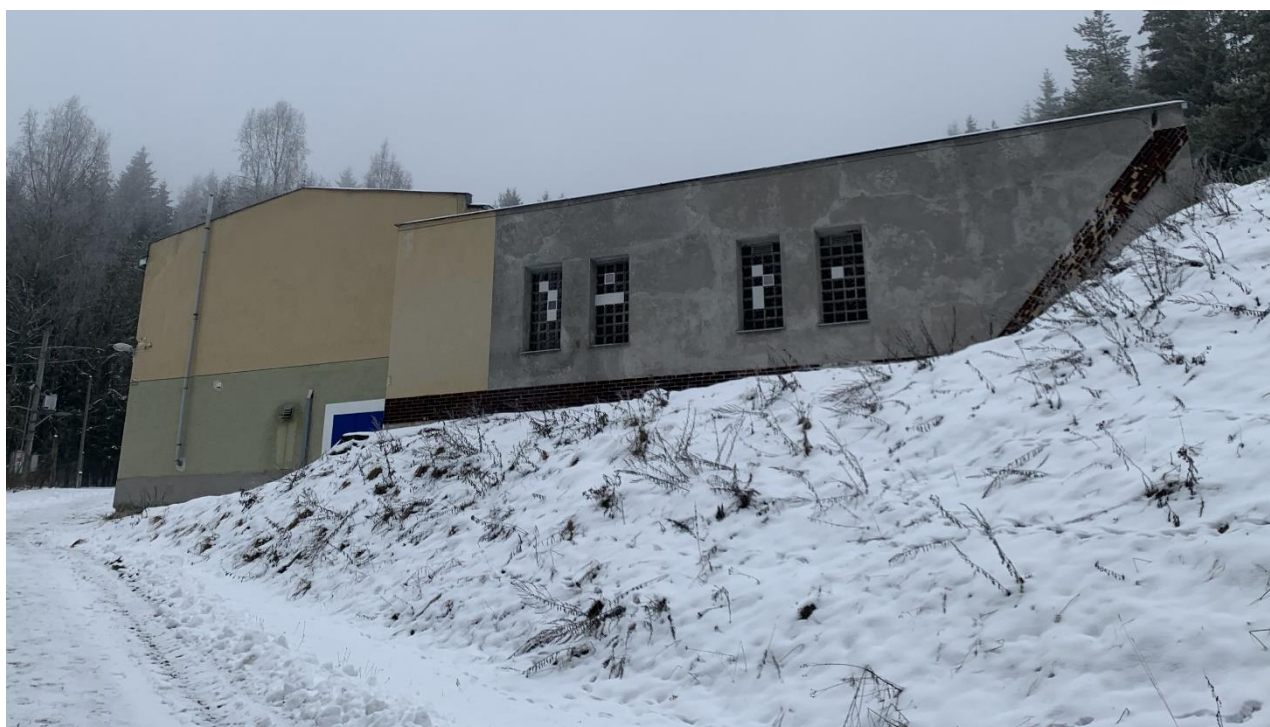
Boční pohled budova úpravný vody Rotava
