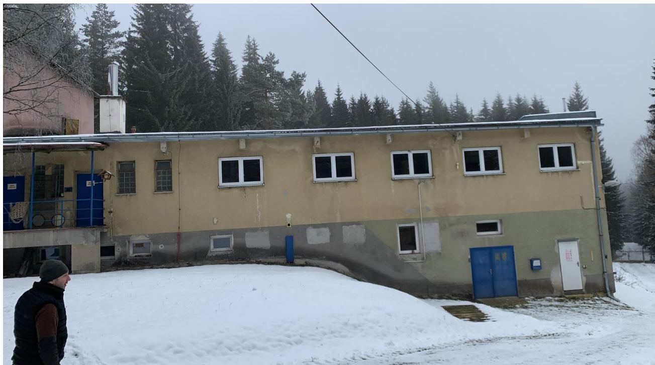
Zadní pohled budova úpravny vody Rotava
