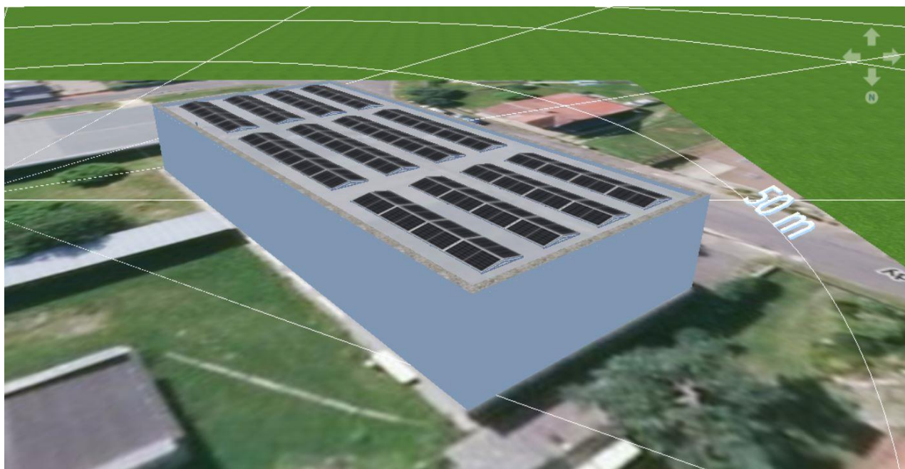
Čelní pohled na budovu ZŠ Rotava pro FVE na pozemku 678
