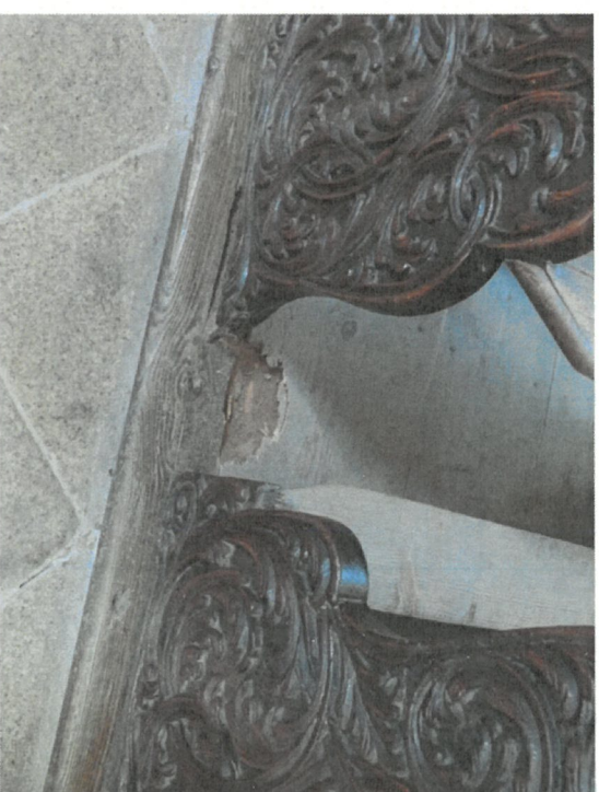
23. Detail poškození podlahy podesty
