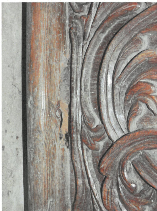
11. Detail lavice. Na snímku je vidět poškození způsobené dřevokazným hmyzem na místě ukotvení bočnice do podešty
