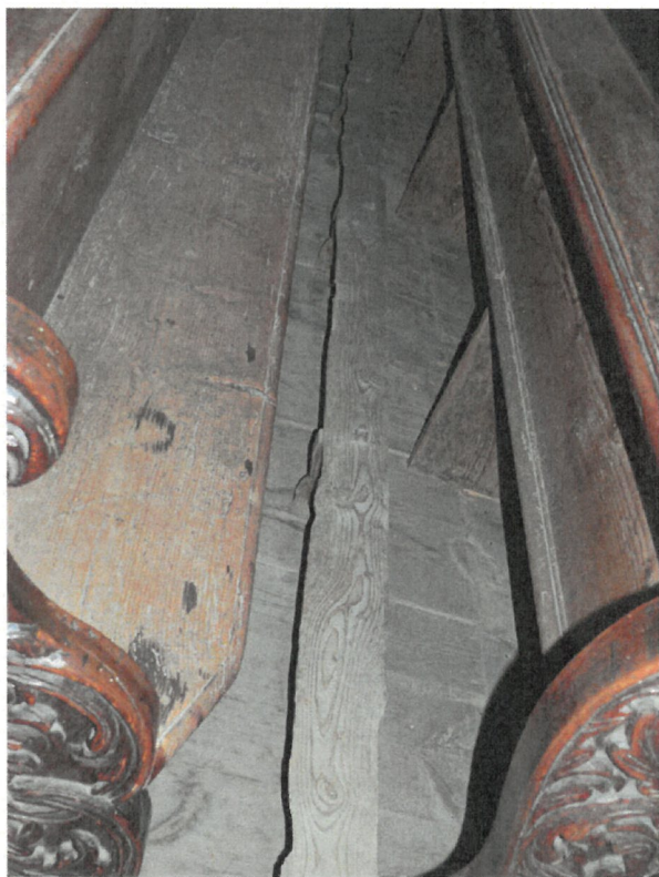
15. Detail konstrukce lavice. Klekátka jsou podepřena čtyřmi podpěrami. Hrana podpěr je tvarována
