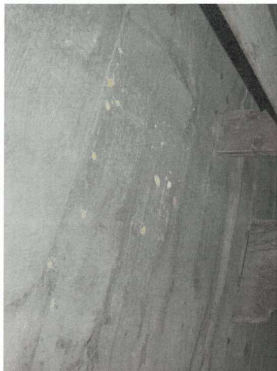
13. Detail lavice. Na snímku jsou viditelné požerky po aktivní činnosti červotoče
