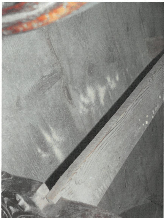
14. Detail lavice. Na snímku jsou viditelné požerky po aktivní činnosti červotoče
