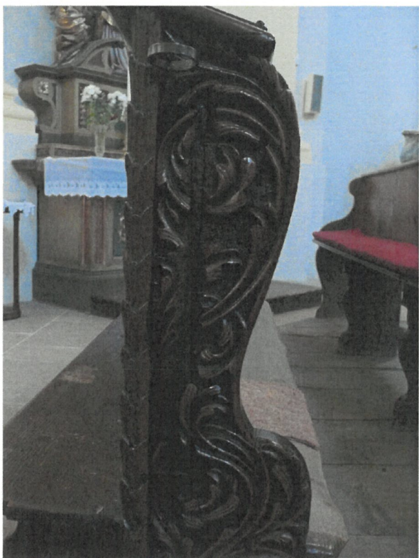
9. Detail poškození řezby akantových rozvilin na bočnici lavice
