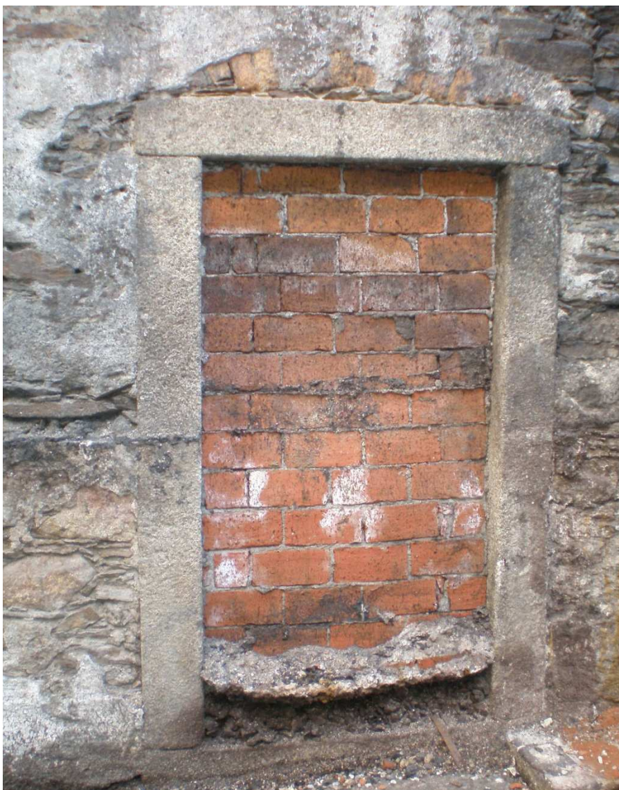
ZAČDĚNÝ VSTUP + OMÍTKA + KAMENNÉ OSTĚNÍ, zpevnění FUNCOSIL 300 KSE
