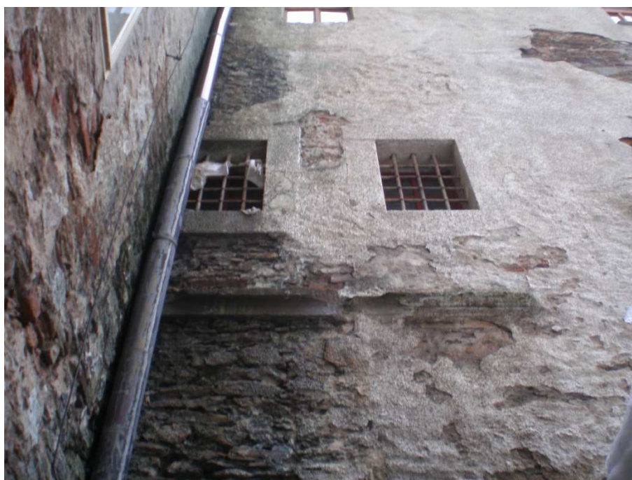
FRAGMENT KAMENNÉHO PARAPETU + KAMENNÉ OSTĚNÍ Š 150 mm 2 KS, zpevnění FUNCOSIL 300 KSE
