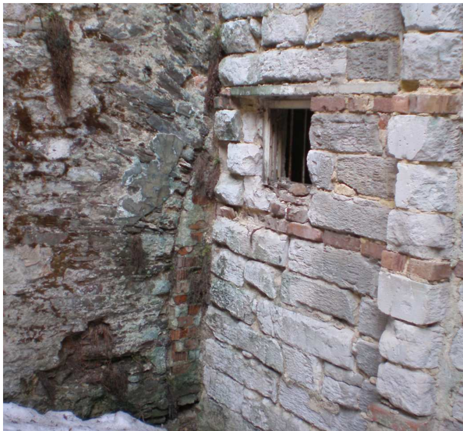
FASÁDA PŘISTAVBY NAD ÚROVNÍ DVORA (omítka zcela chybí)
