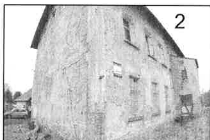
DŮM č.p.112, POHLED VÝCHODNÍ
