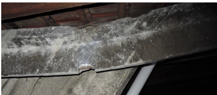
HORNÍ POHLED NA ZLOMENOU KROKEV – VEDLE DŘEVĚNÁ PROVIZORNÍ VÝZTUHA
