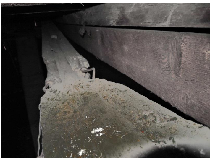
HORNÍ POHLED NA ZLOMENOU KROKEV – VEDLE DŘEVĚNÁ PROVIZORNÍ VÝZTUHA
