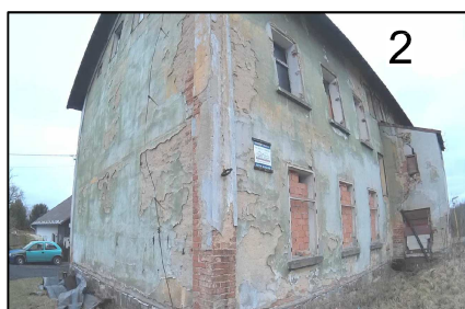
DŮM č.p.112, POHLED VÝCHODNÍ
