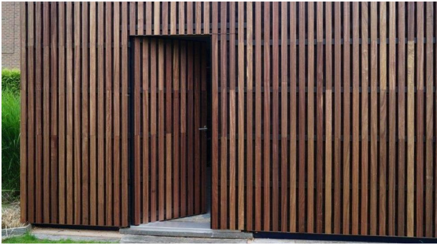
Příklady obkladu ze svislého latování
