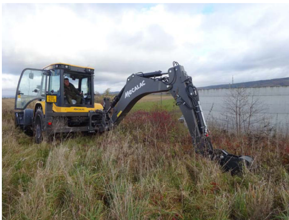
Obr. 4. Realizace kopané sondy KS2.
