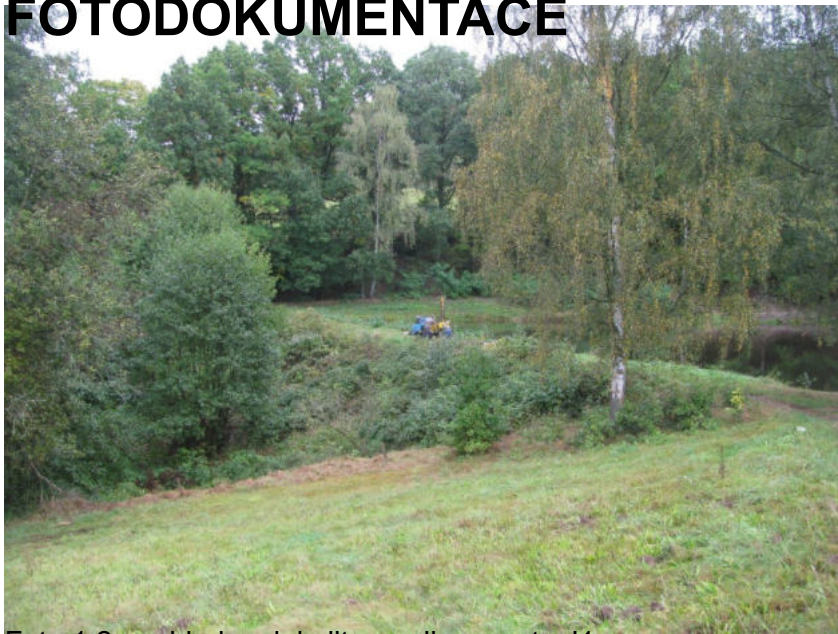
Foto 1,2 : pohled na lokalitu, realizace vrtu J1
