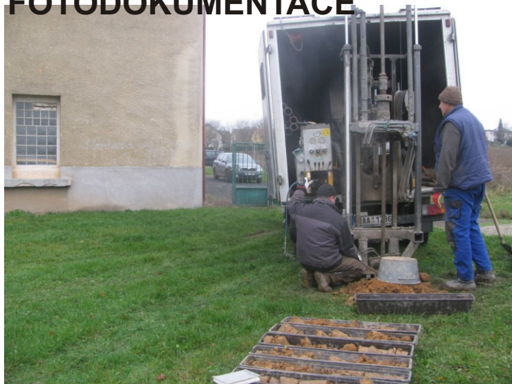
Foto 1, 2 : realizace průzkumných sond
