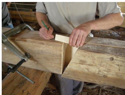
Obr. 30 Orýsování šikmého čela z již zaříznutého protikusu
