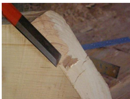
Obr. 32 Osekání nadbytečné délky plátu
