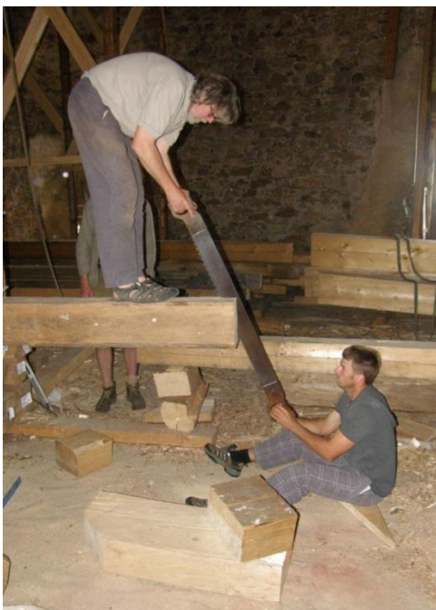
Obr. 22 Řezání podélného plátu pomocí tesařské řetězové pily
