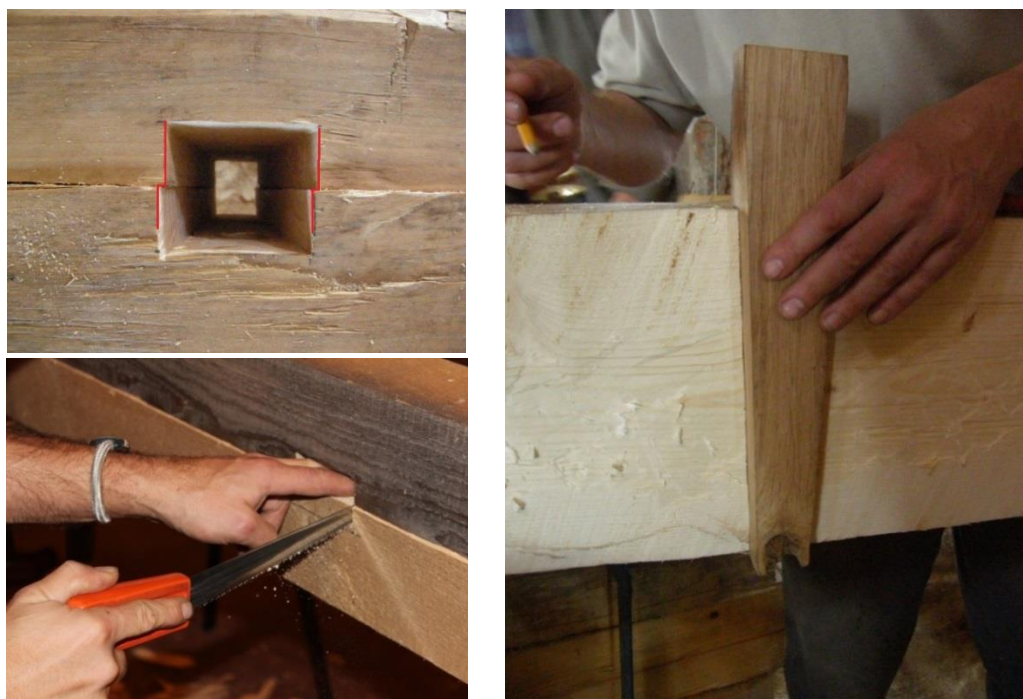
Obr. 34 a) Vyřeznutí drážek pro hmoždík s odsazením umožňujícím rozpěr čel při dotahování hmoždíku (je zvýrazněno barevně; vlevo nahoře), b) kontrola osazení hmoždíku v drážce (vpravo), c) výroba drážky pro hmoždík přímo při sesazení spoje (vlevo dole)
