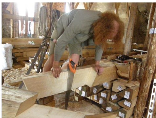
Obr. 29 Příprava drážky pro hmoždík pomocí ruční pily
