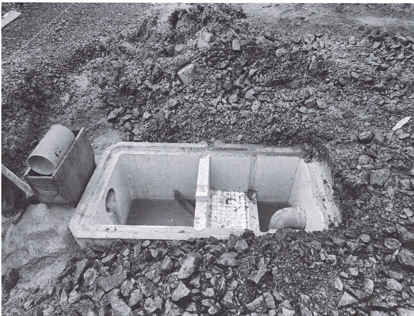
Stavební úprava ulice Karla Čapka, Habartov – II. Etapa Tento zápis je nedílnou součástí stavebního deníku stavby.
