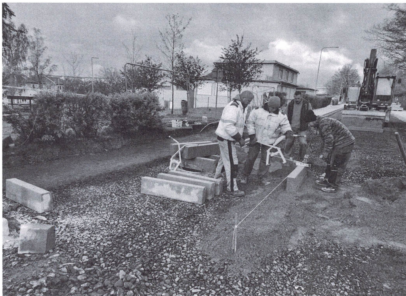
Stavební úprava ulice Karla Čapka, Habartov – II. Etapa Tento zápis je nedílnou součástí stavebního deníku stavby.
