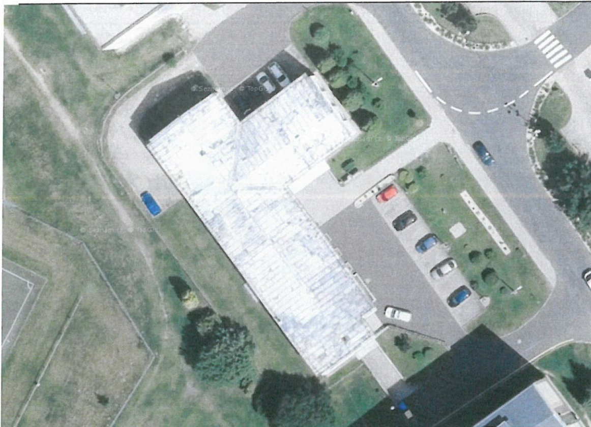
Letecký pohled na budovu městského úřadu Rotava
