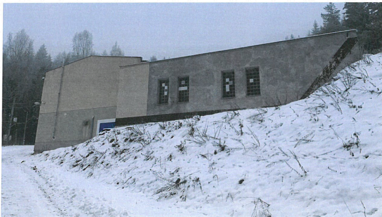
Boční pohled budova úpravy vody Rotava
