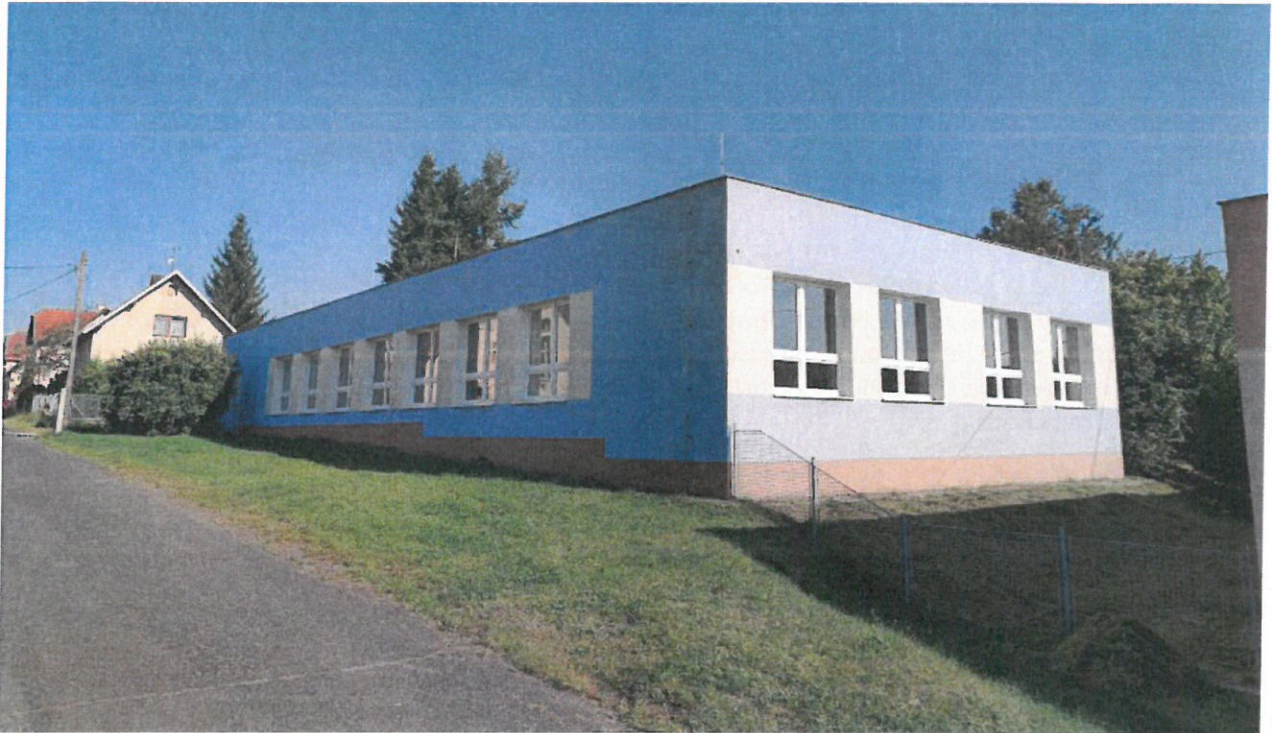
Boční pohled budova ZŠ pro FVE na pozemku 678
