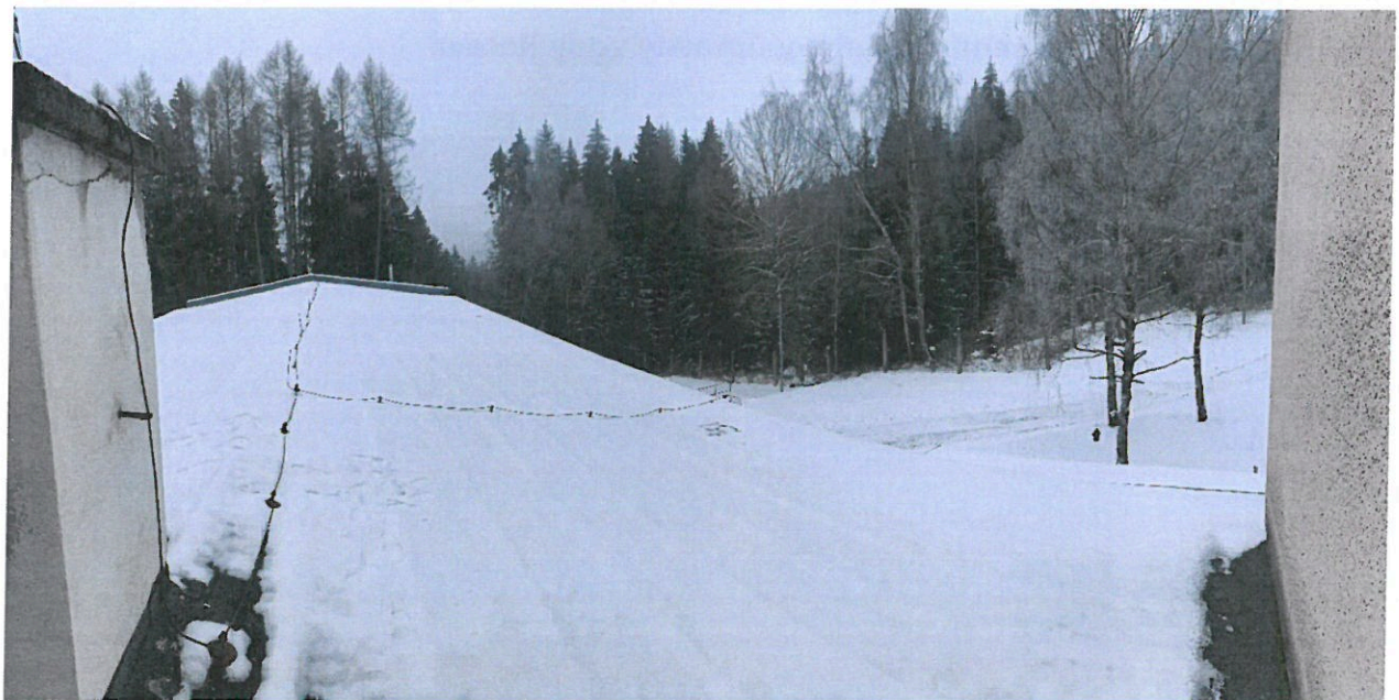
Pohled na jižní část střechy budovy úpravny vody Rotava pro instalaci FVE
