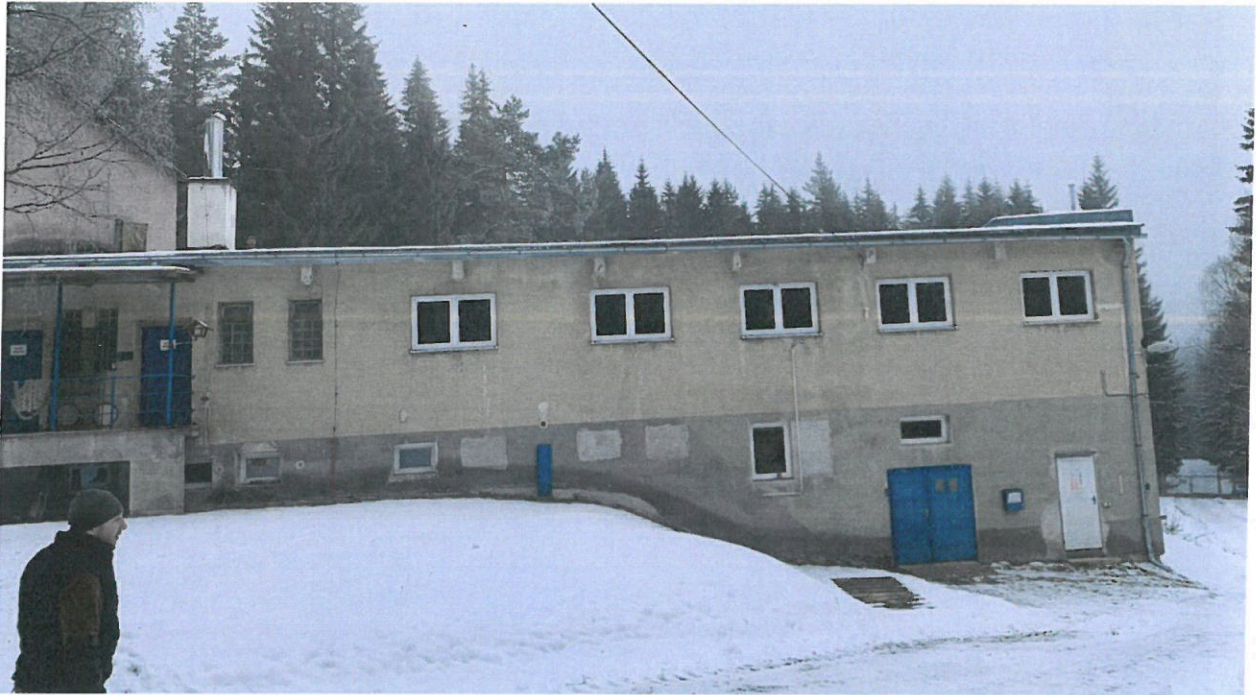
Zadní pohled budova úpravny vody Rotava
