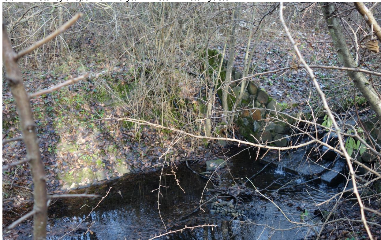
Obr. 4 – Stávající opevnění koryta v místě vyústění V1
