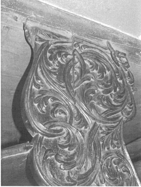
16. Detail poškození řezby akantových rozvilin na boční lavice. Bočnice jsou sklizené z více částí. Spoj je uvolněný
