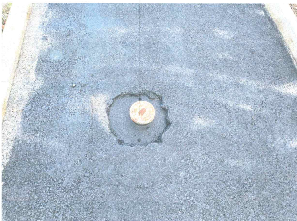
Výšková úprava poklopů.
